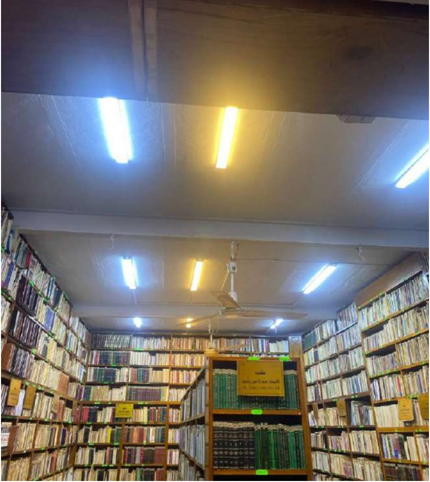
صورة رقم (٢٦) لسقف البناية من الداخل وهو سقف ثانوي وضع حديثا
