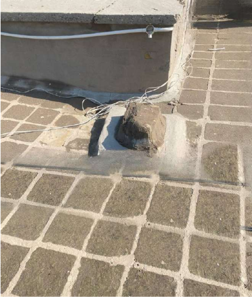
صورة رقم (٤٣) توضح كيفية إغلاق الملاقف من الخارج
