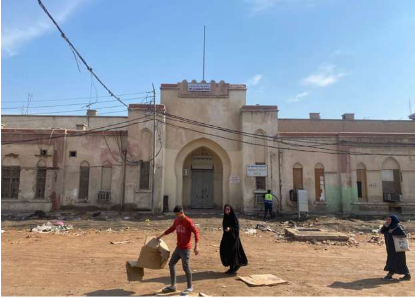
صورة رقم (٢٤) للمدخل الجنوبي للمبنى
