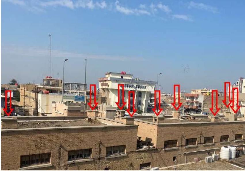
صورة رقم (٤١) البادكير وهو موزع في زوايا سطح المبنى
