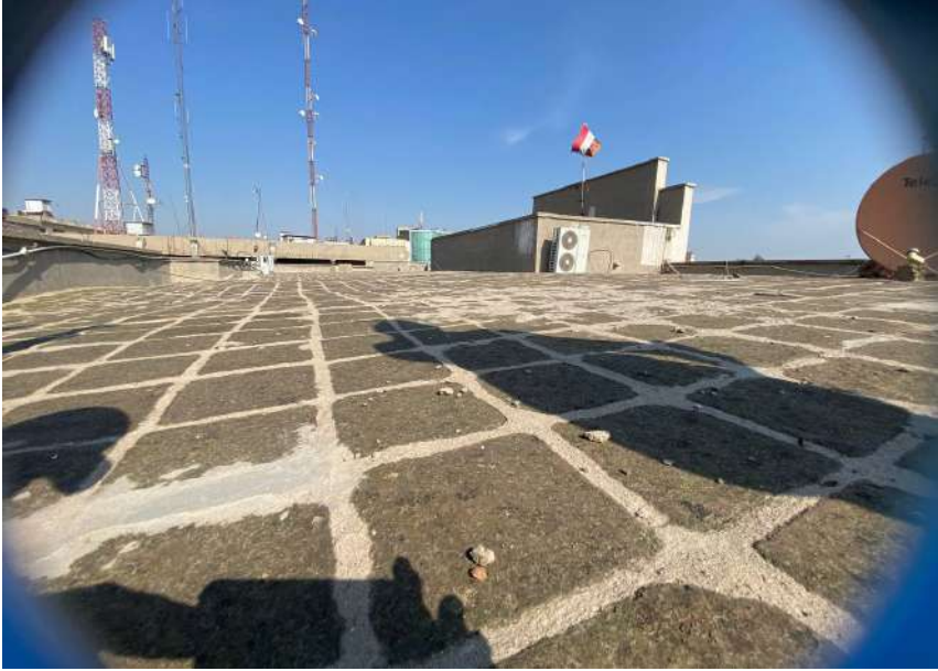
صورة رقم (٢٧) لسطح البناية وهو مبلط بالفرشي ويظهر فيها الانحناء العالي نحو جهة الجنوب لغرض عدم تجمع الأمطار
